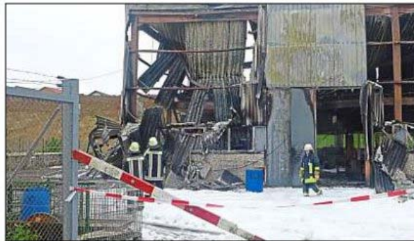
Die Nach-Löscharbeiten an der völlig zerstörten Halle waren auch Stunden später noch im Gange. – Foto: Lampelsdorfer
